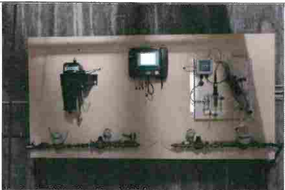
Dispositif de mesure de la turbidité en continu
